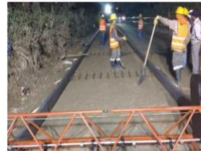
Aplicación de Concreto Hidráulico MR43 margen derecha K0+910 al K0+430.
