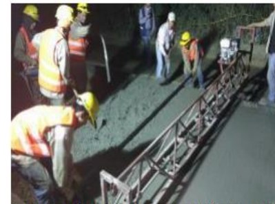
Aplicación de Concreto Hidráulico MR43 margen derecha K0+910 al K0+430.
