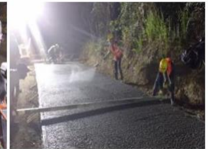
Aplicación de Concreto Hidráulico MR43 margen derecha K0+910 al K0+430.
