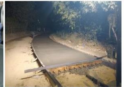
Aplicación de Concreto Hidráulico MR43 margen derecha K0+910 al K0+430.
